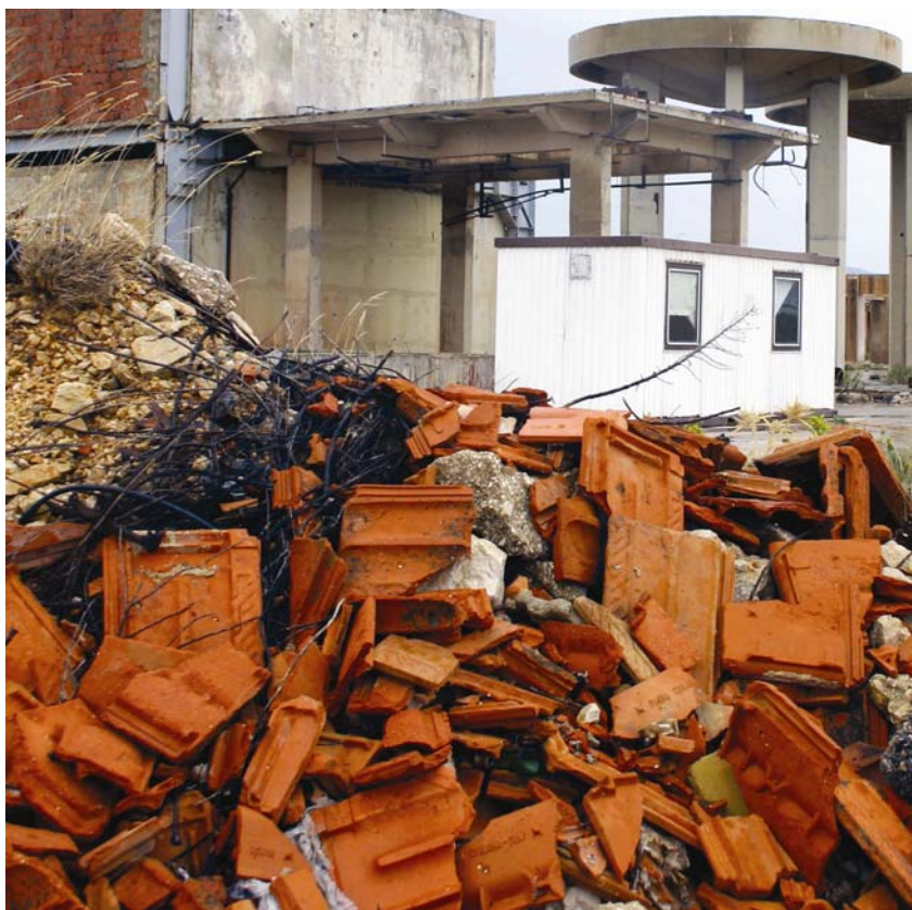
Izolirana opeka odložena uz gradilište najvjerojatnije neće završiti na odlagalištu građevnog otpada
